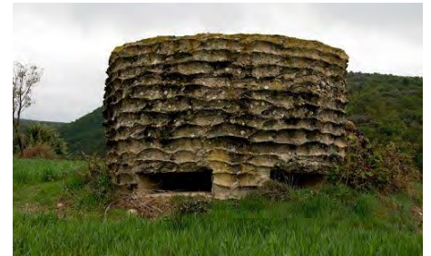
Bunker La Posa (Isona). Photo: Antonio Saez Torrens
