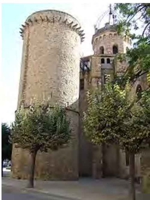
Torre de la Sagristia, de la antigua muralla de Tremp.
